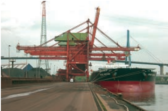
Krananlagen zur Entladung von Schüttgut
